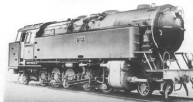
1937 1E1-Heißdampf-Tenderlokomotive — Achsdruck: 23 t für die Preuß. Bergwerks- u. Hütten A.G. Haineburg G/S.
