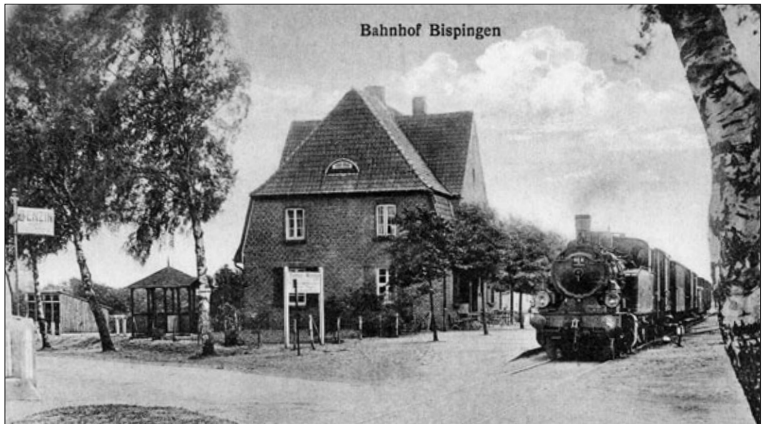
Bild 122 Im Bahnhof Bispingen steht ein von der Lok „No. 8“ gezogener Personenzug. Bei der Maschine handelt es sich um die ursprünglich schmalspurige 1'D1'-Maschine, welche die Kleinbahn von der Lübeck-Büchener Eisenbahn erworben hatte.
